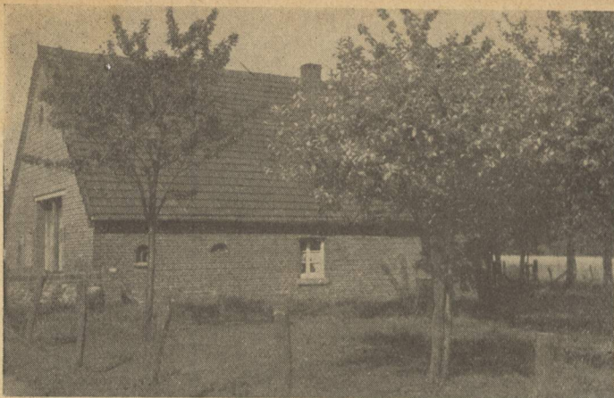
Aeltestes Haus aus der Gründungszeit nach erfolgtem Umbau (Hinterfront)
